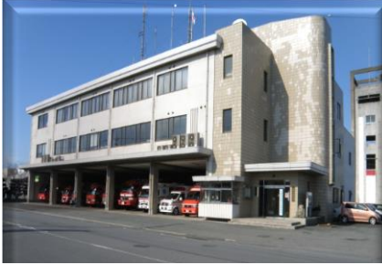
消防局・宇部中央消防署
