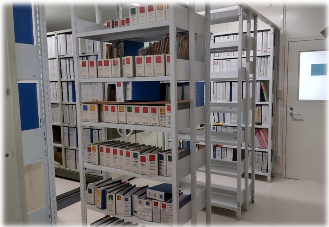
消防局書庫改修
