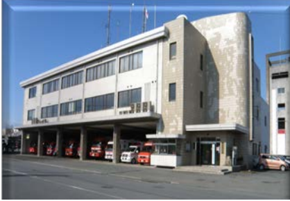
消防局・宇部中央消防署
