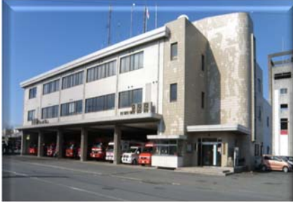
消防局・宇部中央消防署
