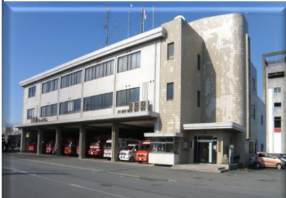
消防局・宇部中央消防署
