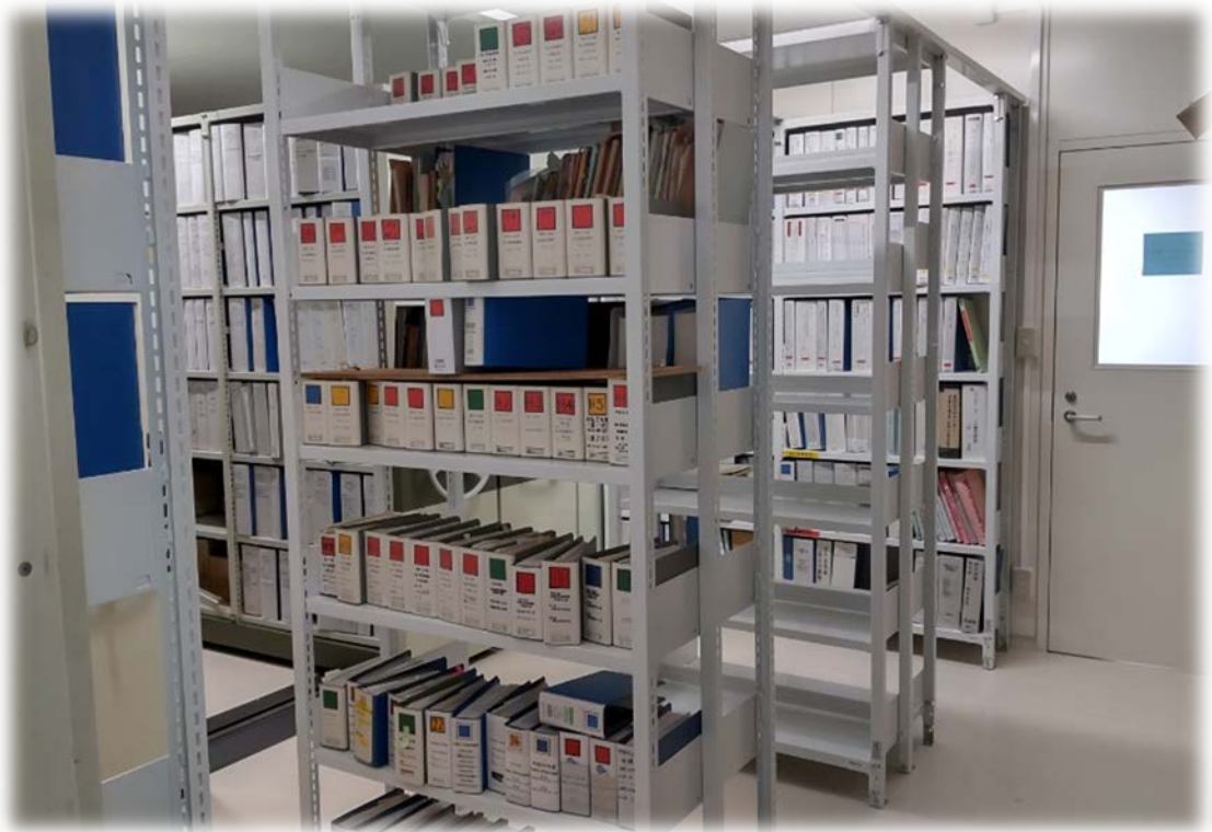
消防局書庫改修
