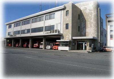
消防局・宇部中央消防署
