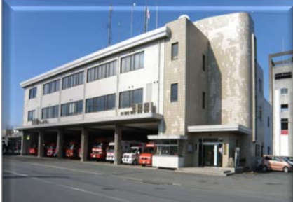
消防局・宇部中央消防署
