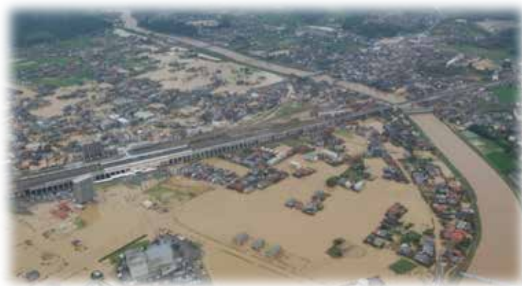
平成22年7月15日大雨災害（厚狭駅周辺）
