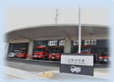
竣工した山陽消防署
