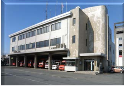
消防局・宇部中央消防署
